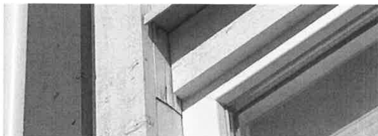
Bilde 3: Skjøt sidebord store vinduer
